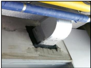
4.1.3. MG-1000 충전 후 MG-1000 주위 및 벽체와 틈새에 MG-158(방화실란트)을 2T 도포(벽체는 양면, 입상은 상부단면)
