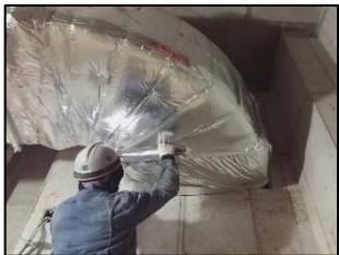
4.1.4. 차열재(38t*400) 밀착 시공
